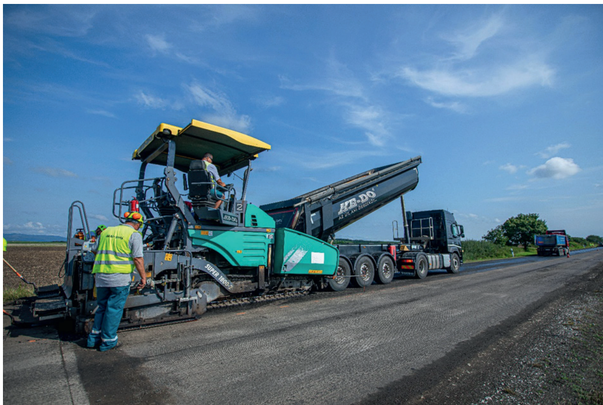
3. sz. főút 114+932-115+632 km bal oldal AC 11 kopó (F) B50/70 + FORTA FI kopóréteg építése
