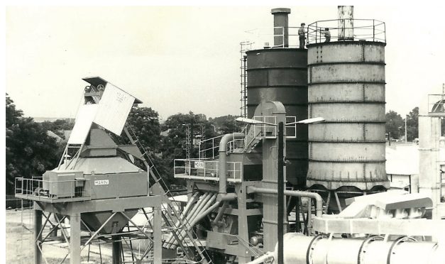
2. kép MARINI 70 P E-180 tip. keverőgép
